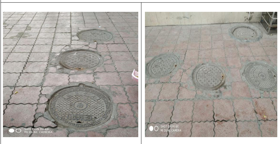
一体化污水处理设施
